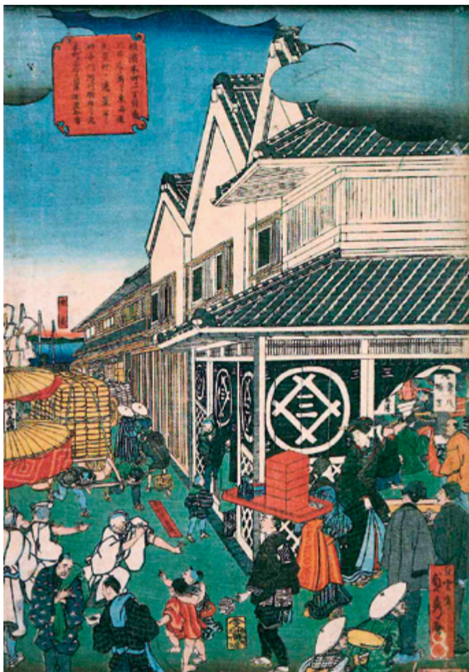
48 横浜本町一丁目角三井店 / 前ヨリ東海道生麦予遠景并神奈川洲崎明神ヨリ此本町壱丁目迄渡船有 現在地: 中区本町4丁目 / 年代: 万延元年(1860) / 作者名: 五雲亭貞秀 江戸幕府は、横浜で外国との貿易を始めるにあたり、江戸の有力商人に出入を命じました。その代表格は三井で、現在の本町通りと馬車道とが交差する、ローソンが所在する角に店舗をかまえました。当時は、本町や弁天通りなどの日本人居住区にある通りは、一丁目～四丁目目が現在は逆の順番でふられていました。大八車に乗せた荷物が行き交い、カニで遊ぶ子どもたちや旅人、頭の上に蕎麦をのせて運ぶ男、店舗の内部など、開港場横浜の繁盛を描いた一枚です。
