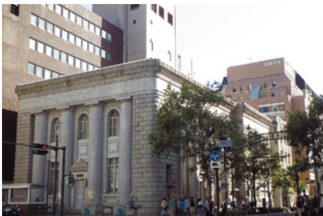
54 東京藝術大学大学院映像研究科(旧富士銀行横浜支店映像文化施設) みなとみらい線 馬車道駅 5・7出口よりすぐ 旧富士銀行の建物であり、2004年まで「BankART Studio 1929 馬車道」だった。この馬車道校舎には映画専攻があり、ほかにもメディア映像専攻は新港校舎、アニメーション専攻は万国橋校舎にある。
