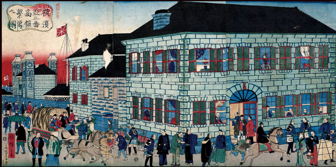
13 横浜亜三番商館繁栄之図 現在地:中区山下町22/年代:明治4年(1871)/作者名:三代歌川広重 表題から、手前に描かれている建物は、アメリカの3番目に建てられた商館であることがわかります。寄棟造り2階建外壁石張り、四隅にキーストーンを配した本格的な西洋建築です。左奥にイギリス領事館が見えているところから、この図が正確に描かれているとすると、当時の居留地22番あたりに該当します。
