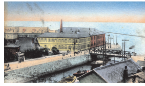
図14 横浜谷戸橋及グランドホテル(1900-1922) 左端の黒い家がヘボン邸
