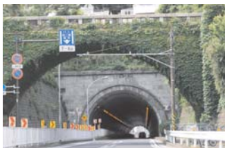
参考：15.桜道橋と山手隧道 (道路面より)
